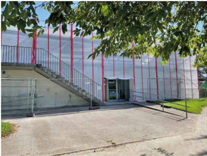
Während der Bauphase
