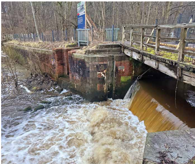
Die Mellingburger Schleuse im Januar 2025. Links davon kann man den Eingang zur ehemaligen Fischtreppe erkennen. Ganz hinten befindet sich der Überlauf.
