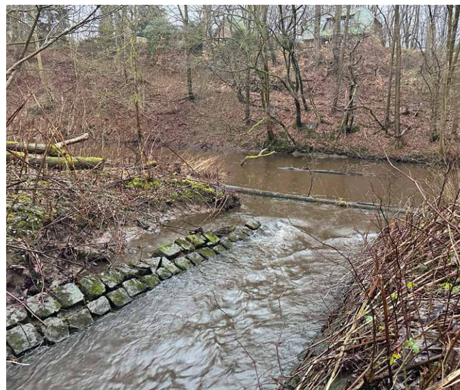
So sieht aktuell der obere Bereich des Überlaufes an der Mellingburger Schleuse aus, wo das Wasser einströmt.
