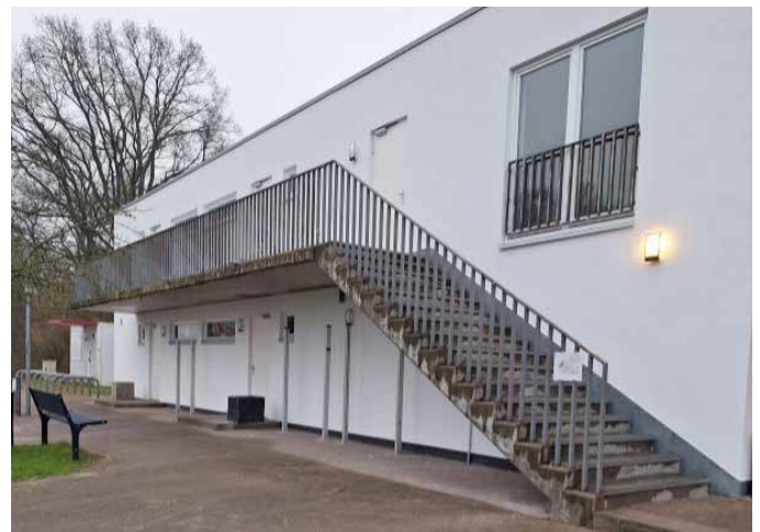
Nach der Fassadensanierung
