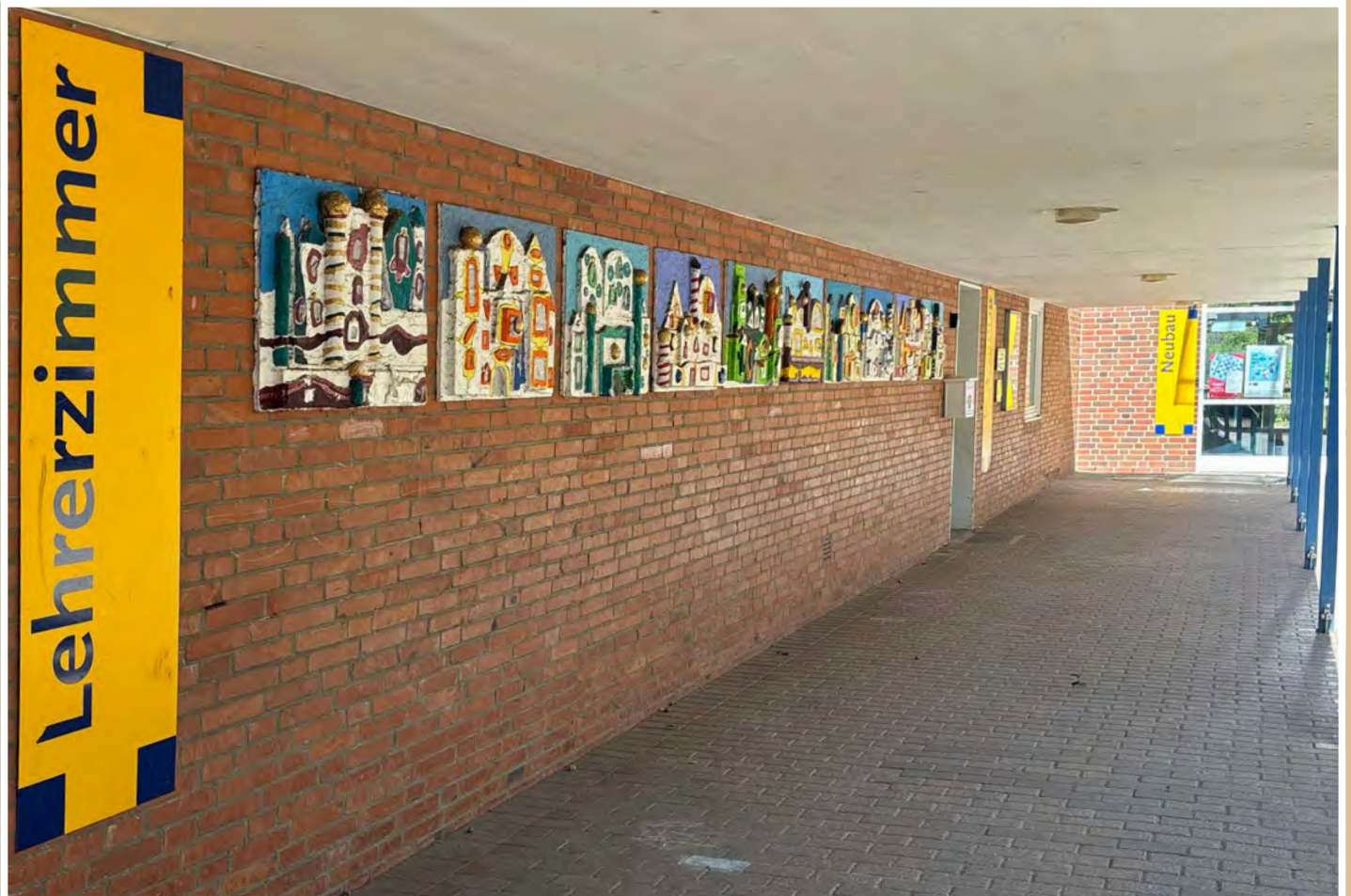
Der Laubengang vor dem Lehrerzimmer und Sekretariat der Grundschule Redderburg
